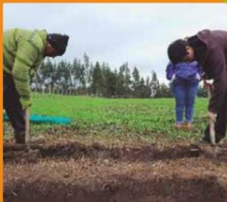
Cuarto, en la parte posterior del pozo, alejado mínimo unos 50 centímetros, se cava una zanja la cual se rellena con bolones en la base y luego con ripio. Esta intersectara el agua y la infiltrara hacia el poco.
