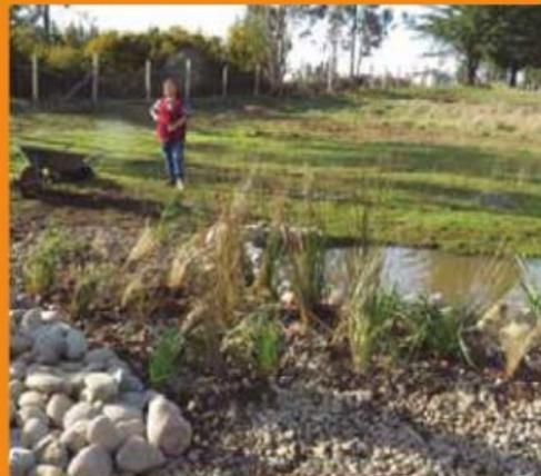
Tras los juncos trasplantados se genero un pozo de infiltración el cual se relleno con bolones hasta mas allá del nivel del suelo con el objeto de darle resguardo y un área de acumulación de agua, evitando su exposición a las altas temperaturas.
