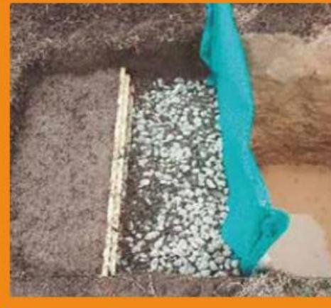
Sexto, una de las zonas divididas por el madero se rellena con ripio y la posterior con barro del fondo del pozo, el cual se aprieta. Además, se coloca provisoriamente una malla que controle la erosión, de sombra y se ancla con bolones de piedra.
