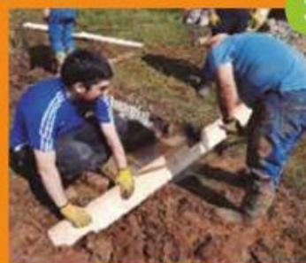
Tercero, se entierra una tabla con rebaje para el paso del agua que actúe para soporte y contención de la estructura de polines que se montara sobre ella.
