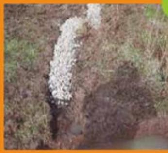
Segundo, se marcan los drenajes que conectarán cada una de las piscinas y se excavan a profundidad de una pala para rellenarlos inmediatamente con ripio y así aminorar la velocidad del agua como la capacidad de erosionar.
