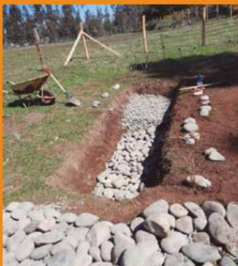
Luego se cabo el área para generar filtro de agua que conduzca y capte la vertiente, de 4 por 1,5 metros y se relleno con bolones, ripio y bolones.
