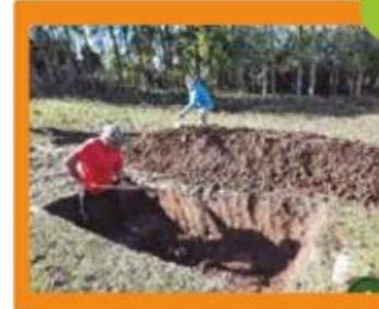
Se marca el área donde se generará el jardín de lluvias y se comienza a excavar acumulando la tierra que se saca a un costado para formar un camellón, idealmente, se debe ir acomodando en forma inmediata para evitar caiga nuevamente a la excavación.
