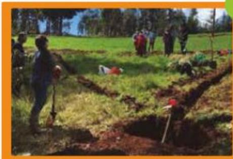
Segundo, se debe profundizar la zanja unos 30 centímetros y ser del ancho de la pala.
