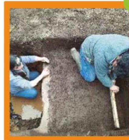
Tercero, una vez que llegamos a la zona donde el suelo presenta condiciones para almacenar agua, detenemos la excavación, dado que debe estabilizarse esta zona antes de poder seguir con la excavación (par de meses). Luego, con el material extraído, ayudado de una piedra, se pulen las paredes del pozo para evitar posteriores derrumbes y se comienza a trabajar en el área donde se dispondrán las zonas de filtro para ayudar al escurrimiento del agua.
